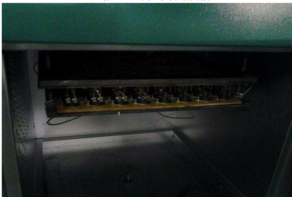
双路 KSD 测试专用烘箱内部
